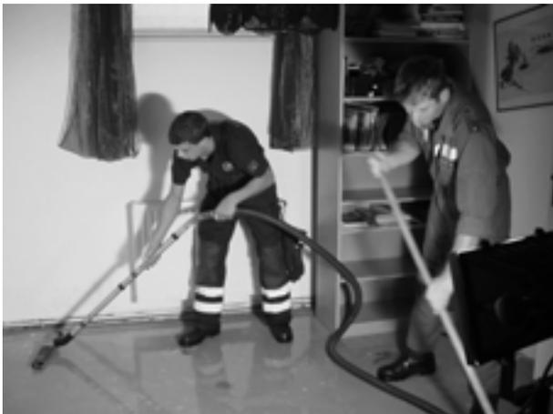
Durch einen defekten Gartenschlauch drang Wasser über einen Lichtschacht in den Keller eines Einfamilienhauses. Als Erstmaßnahme wurde von der Feuerwehr Laxenburg der Strom im Keller durch Abheben der Sicherungen abgeschaltet. Danach konnten wir mit unserem Nassstaubsauger den überfluteten Keller mit einem anfänglichen Wasserstand von ca. 5cm völlig auspumpen.
